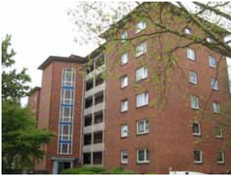
Wohnungsbestand in der Billrothstraße
