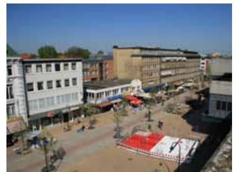
Ursprüngliche Gestaltung der Kommunaltrasse 2006
