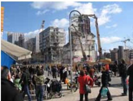
Abriss des Frappant-Gebäudes 2011
