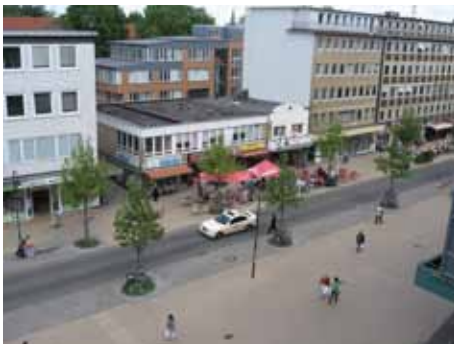
Kommunaltrasse in der Großen Bergstraße
