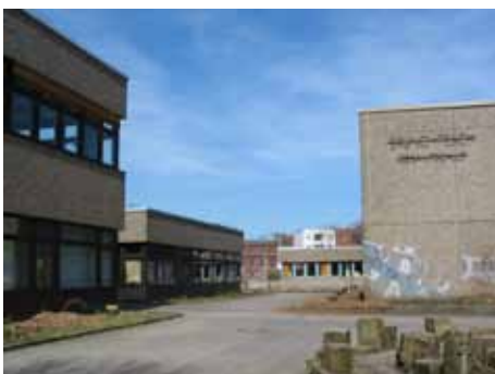
Gebäudebestand der Bruno-Tesch-Gesamtschule 2006
