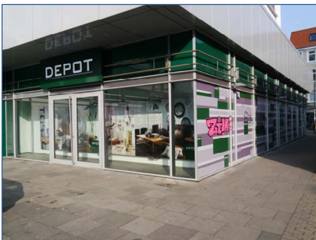
Großflächig abgeklebte Schaufensterfronten
