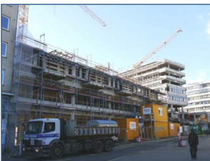
Baumaßnahme Neue Gr. Bergstr. 18
