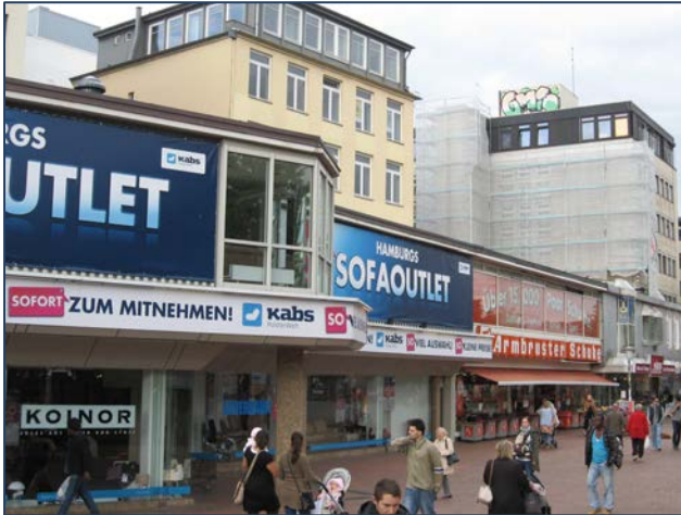
Großflächige Werbeanlagen in der Neuen Gr. Bergstraße
