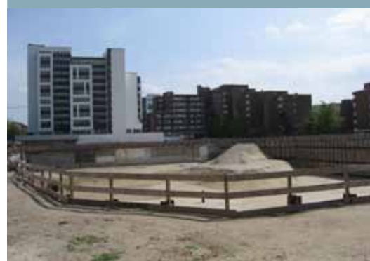
Über Monate passierte nix in der Baugrube an der Großen Bergstraße
