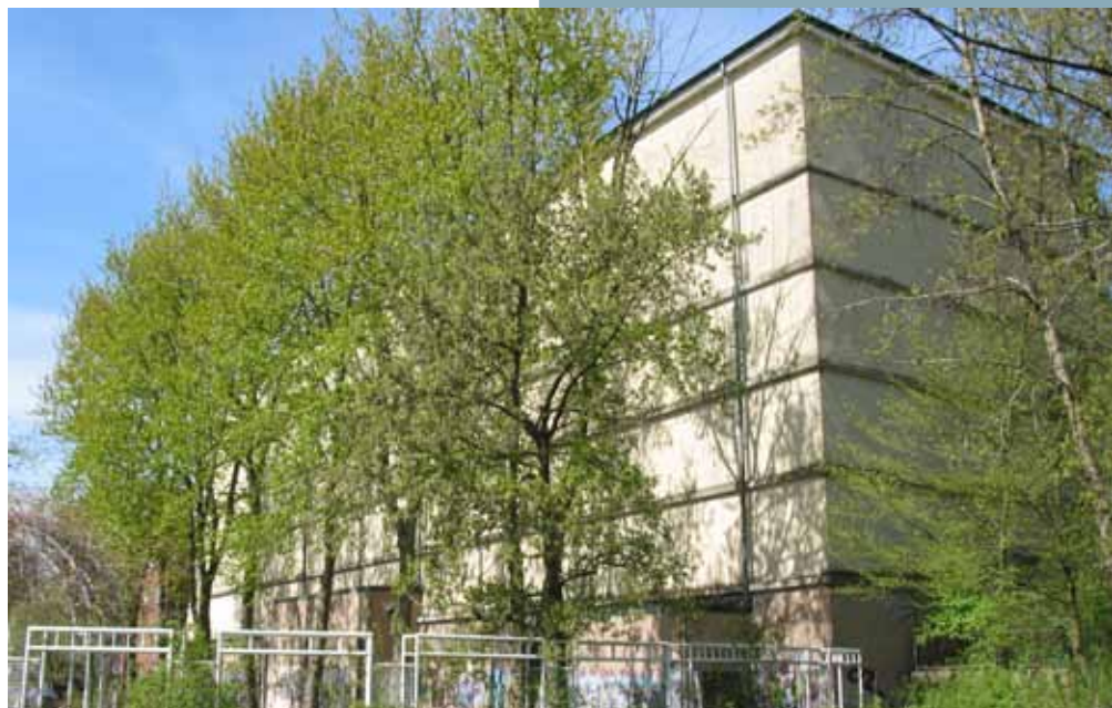
Das Objekt der Begierde: Der Bunker an der Schomburgstraße
