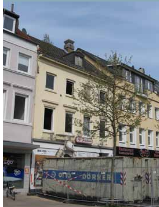
Entkernungsarbeiten in der Großen Bergstraße 167
