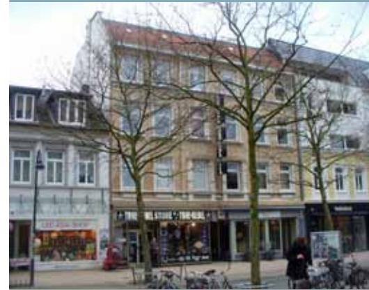
Bestandsfassade zur Großen Bergstraße
