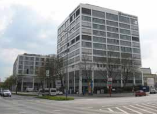
Sanierter Altbau mit dem dahinter liegenden Neubau
