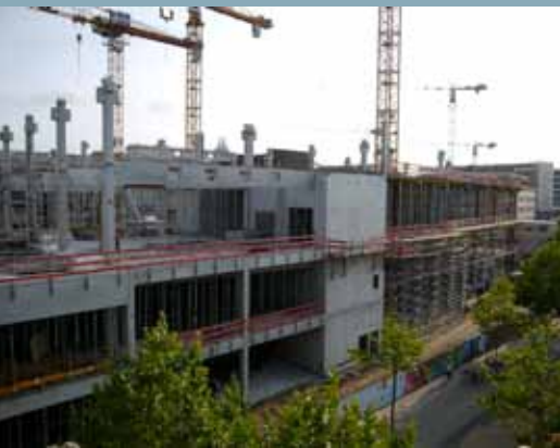
Blick auf die IKEA-Baustelle aus der Großen Bergstraße
