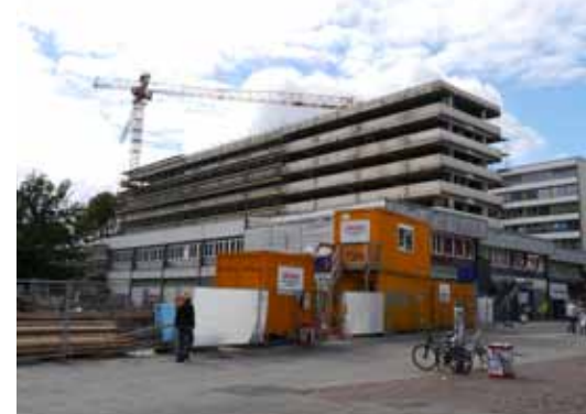
Bauarbeiten am Büro- und Geschäftsgebäude Schillerstraße 44
