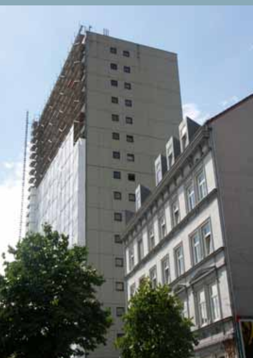
16-geschossiges Bürogebäude am Bruno-Tesch-Platz
