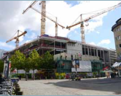
Blick auf die IKEA-Baustelle vom Goetheplatz
